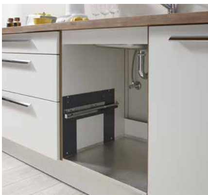
Instalar las guías
