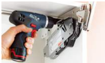
Con el equipo de atornillado con batería (Pozidriv®, tamaño 2, longitud 39 mm), se ajusta la fuerza correctamente sobre el peso de cada frente. Para ello se utiliza una regla graduada.
